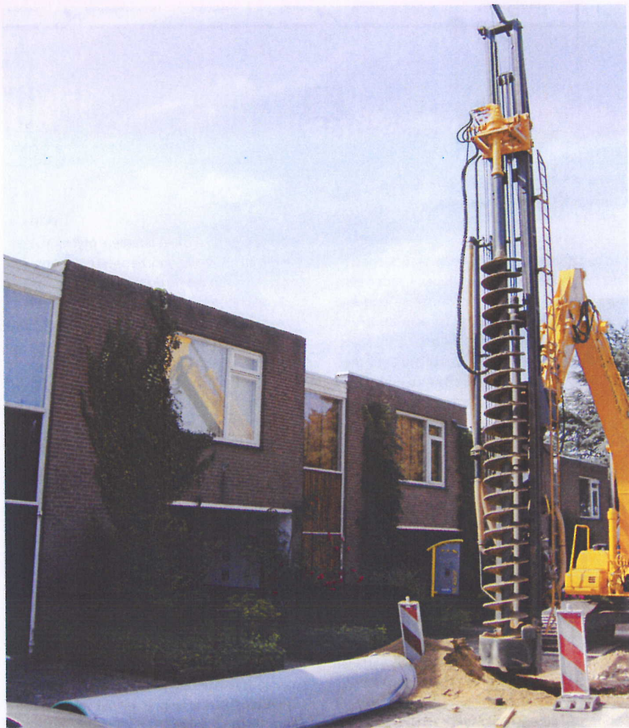
Realisatie van een droge infiltratiebron.
